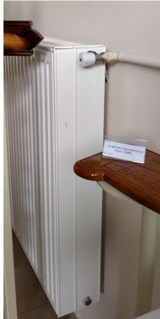
Új radiátor hagyományos szeleppel
