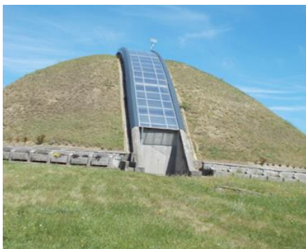
A profilüveg tetőszerkezet
