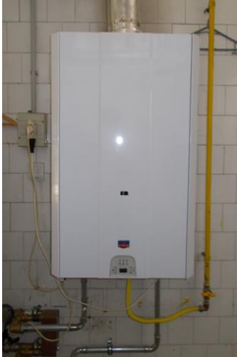
Atmoszférikus gázkazán a prospektúra épületében
