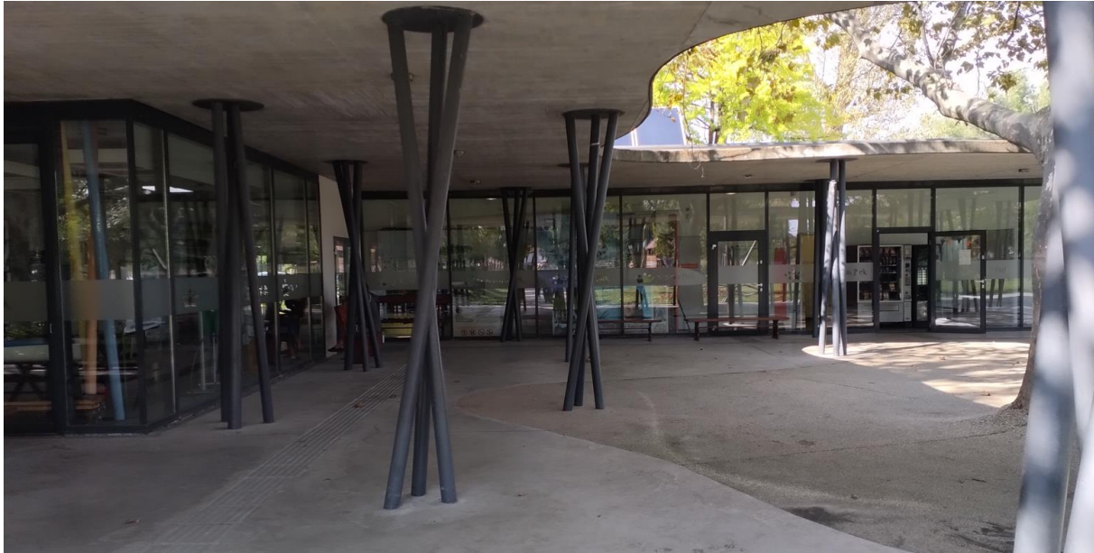
A játszópark főépülete
